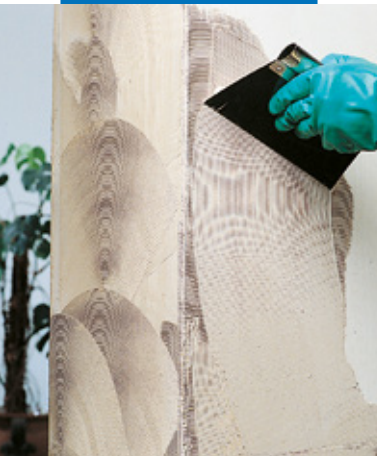
Stesura di Adesilex VS45 con spatola n. 1
